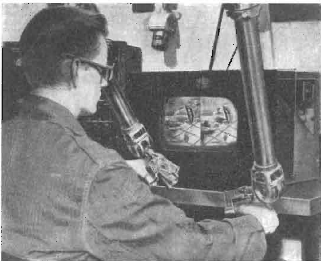
Apparecchiatura di televisione tridimensionale realizzata dalla Du Mont per la manipolazione a distanza di sostanze radioattive nei laboratori di ricerche atomiche.
